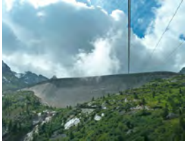
1 Die Albigna-Staumauer im Bergell von unten gesehen.
